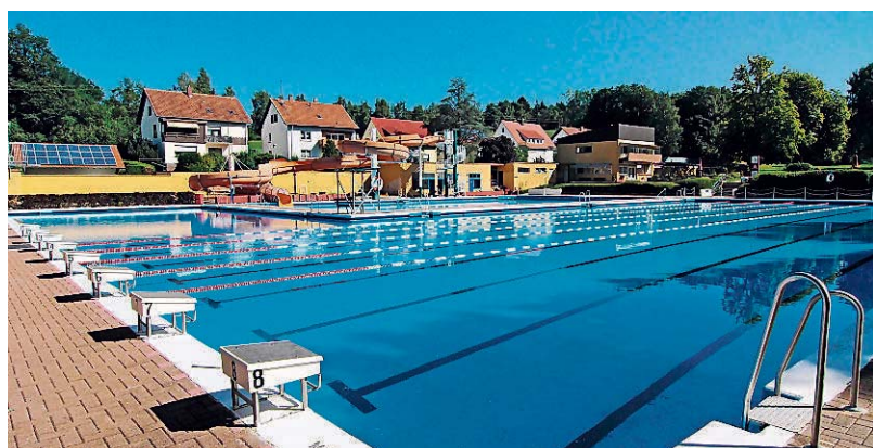
Ansicht des St. Wendeler Freibades vor dem Beginn der Umbau- und Sanierungsarbeiten. FOTO: B&K
